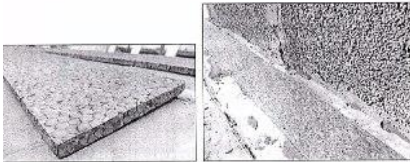
تصویر باند EEPS اجرا شده از این باند در قسمت زیرین چهارچوب نصب دیوارها
